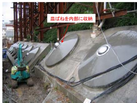
Photo. 5 変位吸収型アンカー用受圧板
