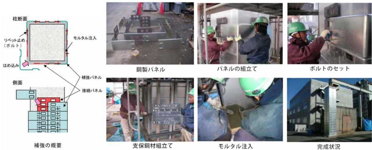
Fig. 6 RC柱の耐震補強工法・鋼板パネル工法
