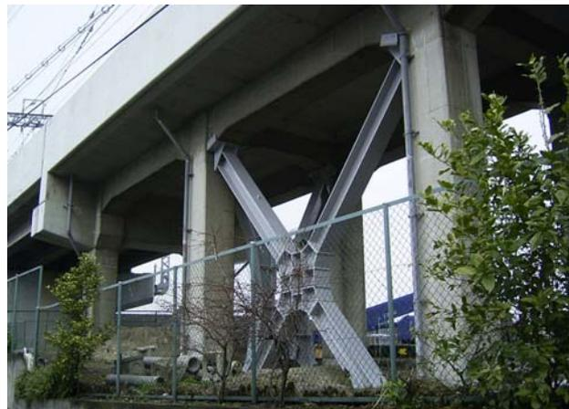
Fig. 7 圧縮型ダンパー工法
