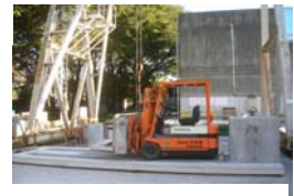
Photo 3 試験状況 Loading Situation
