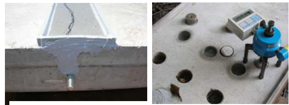
Photo 2 水張り試験 Water Leakage Test
