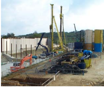
Photo 1 ソイルセメント工事 Construction for Using Soil Cement
