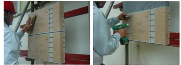
たたき押えのみ 振動工具の併用
