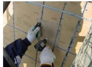
④ 振動工具を併用し、十分にもみ込む。
