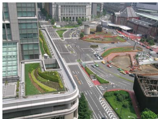
Photo 6 熱画像撮影時の屋上緑地と東京駅丸の内口周辺 The Rooftop Green and Tokyo Station
