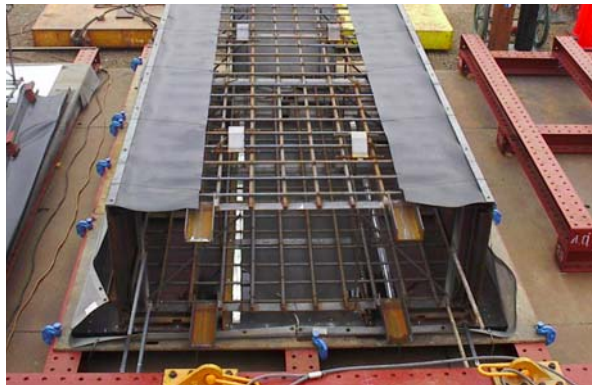
試験体鉄筋かご製作状況
