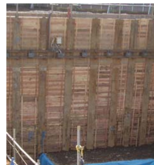
Photo 14 ハイスペックネイリング工法 の山留め支保工への適用 Application of High-Spec-Nailing
