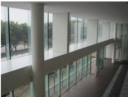
Photo 3 超高強度 CFT 柱 Ultra High Strength CFT Column
