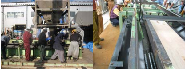
Photo 4 ホッパーによる打設作業 Mortar Placing by Hopper
