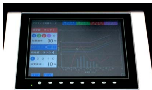
Photo 3 振動表示モニター Vibration Monitor of the Bridge
