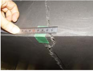
Photo 9 最大耐力時のひび割れ Crack at Maximum Load
