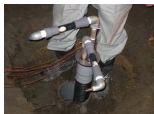
Photo 2 コルゲート管試験体 Corrugate-tube model
