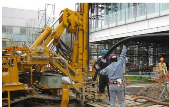
Photo 3 新本館でのコルゲート地中熱交換器施工状況 Example of construct on the Underground Heat Exchanger
