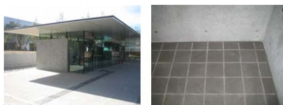
Photo 3 適用状況 (再生コンクリート, タイル) Applied situation (Recycled Concrete, Clay tile)
