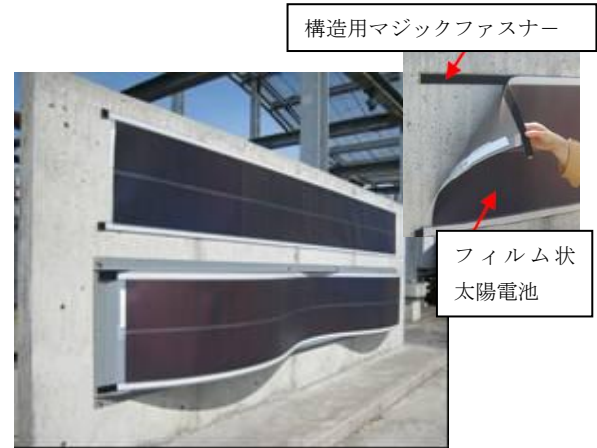
Photo 2 モックアップ試験体 Example of Mock-up
