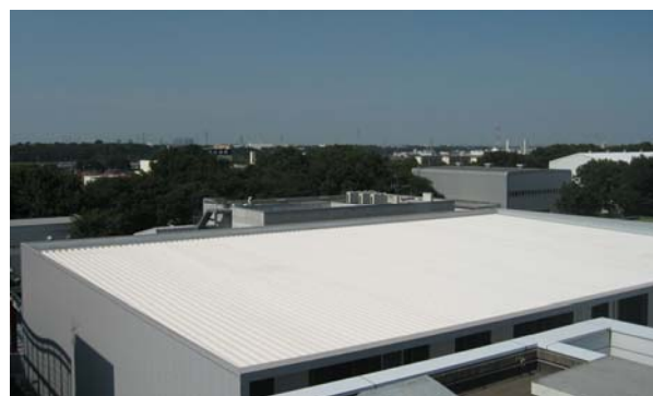
Photo 5 技術研究所オープンラボ屋根に塗装したサンバリア “Sun-Barrier” Painted on Folded-plate Roof of Open-laboratory in Technical Research Institute
