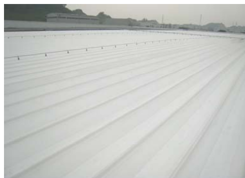
Photo 4 某工場屋根に塗装したサンバリア “Sun-Barrier” Painted on Folded-plate Roof of Factory
