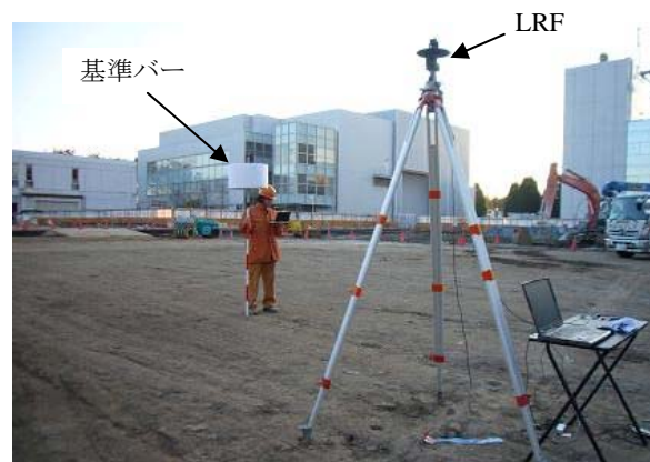
Fig. 14 LRFを用いた杭芯位置計測の準備作業状況 Site Calibration of Position Measurement System Using LRF
