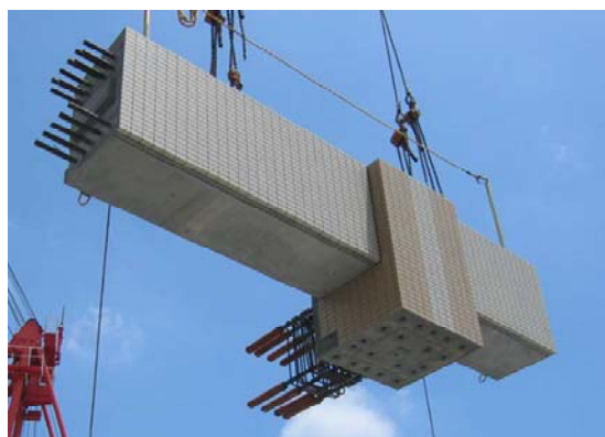
Photo 1 LRV工法のプレキャスト部材 The precast beam-column joint of LRVmethod
