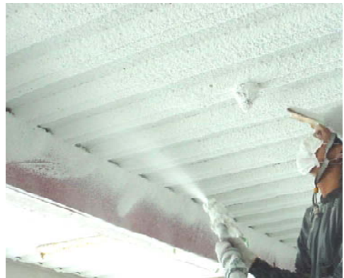
Photo 3 セラミライトエコ G Construction of cerami light eco G
