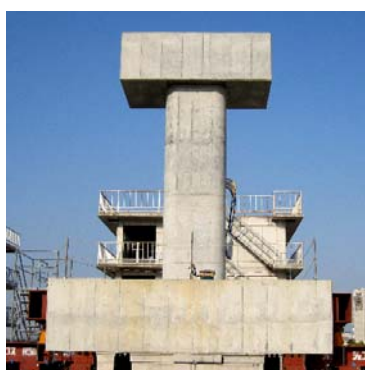
Photo 5 実大橋脚試験体完成 C1-6 Column
