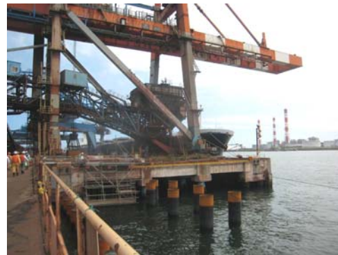
Photo 8 補修した棧橋構造物の全体 Whole of the repaired pier
