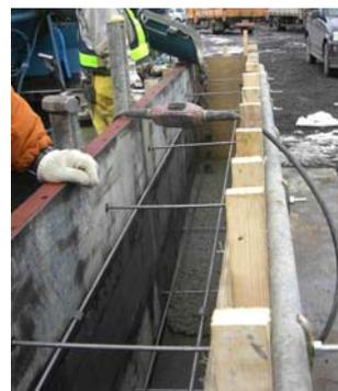
Photo 4 コンクリートの打込み状況
