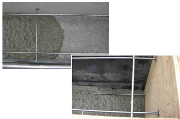
Photo 6 スムースクリートの打込み時の流動先端状況
