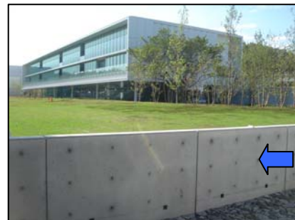
Photo 3 クリーンクリートを適用した外構立上り壁の外観 View of Concrete Fence Wall by Crean-crete
