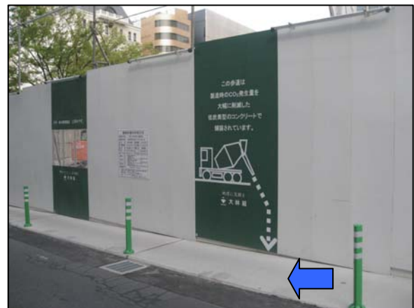
Photo 5 クリーンクリートを適用した歩道の外観 View of Temporary Sidewalk by Clean-crete
