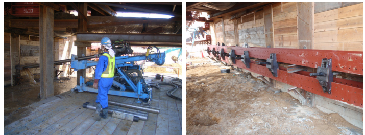
Photo 3 適用現場の施工状況 Construction Case
