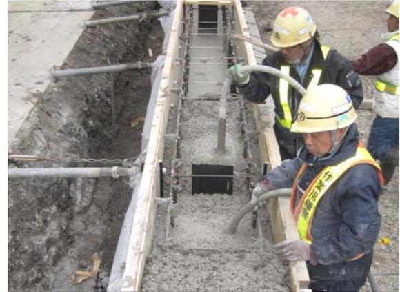
Photo 4 コンクリートの締固め状況
