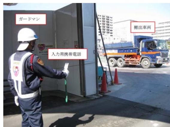
Photo 3 携帯電話を利用した車両入退場管理システムの利用状況
