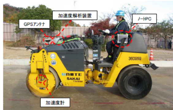
Photo 1 使用したローラ (4tコンバインドローラ) Heavy machinery used to field test (4t combined vibrating roller)
