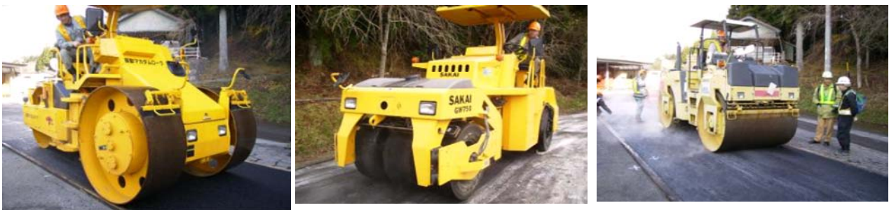
Photo 2 試験に用いたローラ (左から、振動マカダムローラ，振動タイヤローラ，振動タンデムローラ) Test construction machineries (Vibrating macadam roller, Vibrating tire roller, and Vibrating tandem roller)
