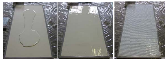
1)大形タイル裏面へ裏打ち処理材塗布 2)立体繊維材料の貼付け
