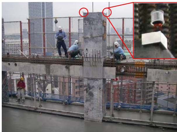
Fig. 11 3次元計測システムによる計測作業 New Style Surveying with 3D Surveying System
