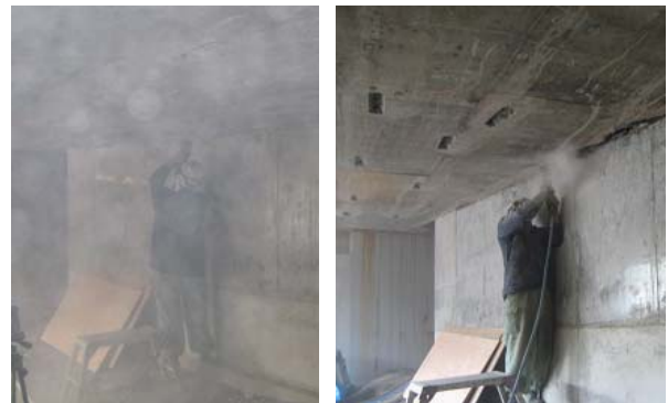
(a) 回転カッターでの切削状況 (b) チッパーでのはつり状況 Cutting by Air Cutter Chipping by Air Chipper
