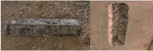
(a) 切除したスペーサの形状 (b) 切除後の床版面 Removed Spacer After Removal of Spacer
