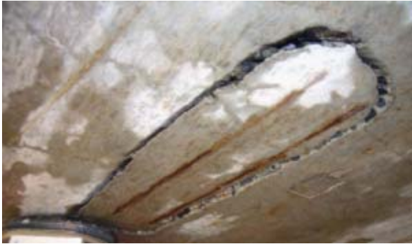
Photo 10 本システムによる切除状況 Cutting Corroding Spacer by Water Jet System
