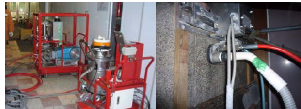
(a) システムの設置状況 Setting the System in the Facility (b) 直線軌道のノズル移動 Setting the Nozzle Unit
