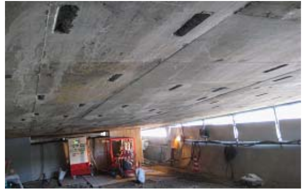
Photo 11 システムの配置と切除後の床版 Result of Removal of Exposed Corroding Spacer
