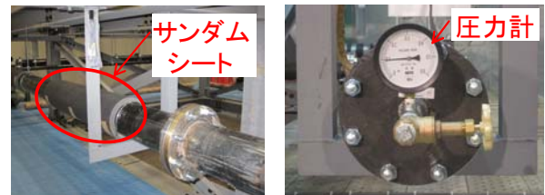
Fig. 3 サンダムシートの貼り付け Horizontal Piping with Sheets
