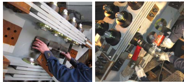
(a) 摩擦板取付け (b) ダンパー部ボルト締付け
