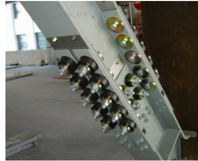
Photo 1 建築分野におけるブレーキダンパーの適用例 Application of Brake Damper for Building
