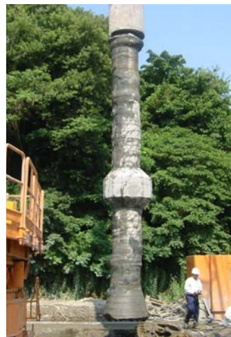
Photo 1 節付き場所打ち杭 2) Cast-in-Place Concrete Nodular Pile
