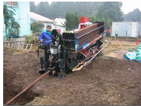
Photo 1 自在ボーリング機 Machine of Long Pre-supporting Systems
