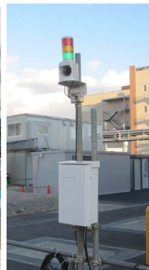
Photo 2 屋外警報灯 および制御盤 Warning Light and Control Box
