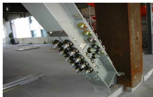
Photo 6 ブレーキダンパー Brake Damper
