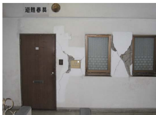
Photo 1 RC壁の防火区画被害状況 4) Damage of a RC Fire Wall
