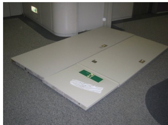
Photo 3 ヒンジから脱落した防火戸の例 1) A Fire Door falling down from Pivot Hinges
