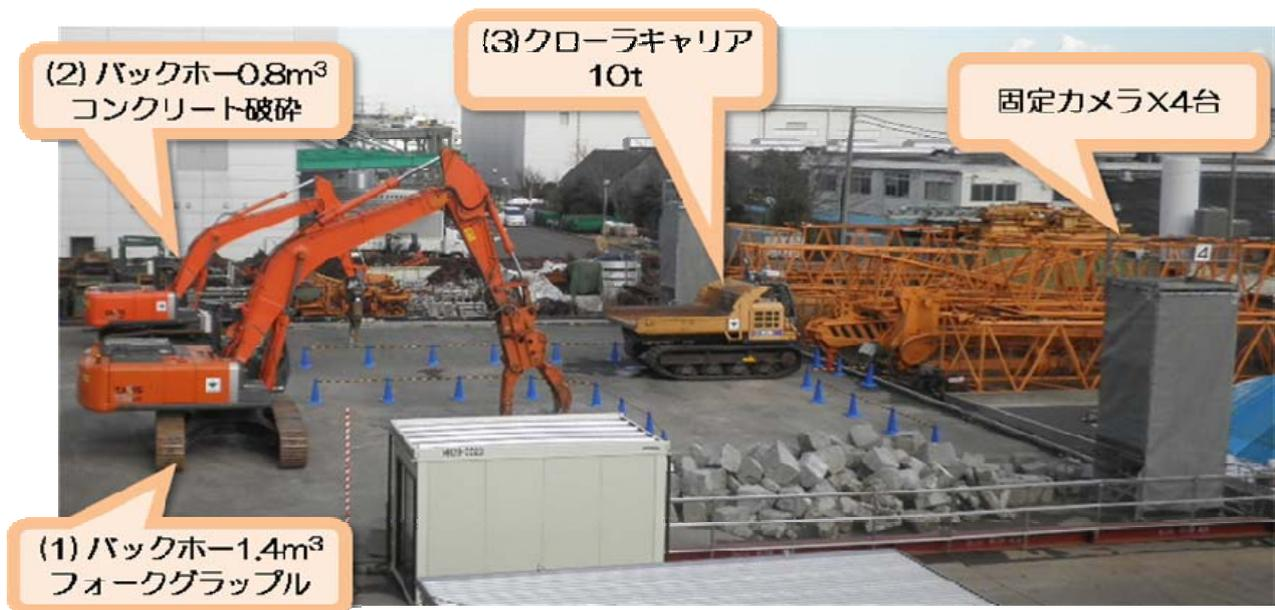
Fig. 4 実験概要(実験に使用した機械と配置)
