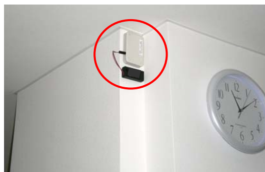
Photo 3 センサユニット実装状況 (SVA) Sensor Unit in the Testing Building
