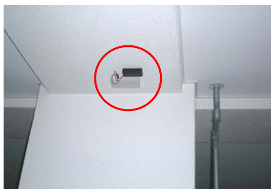
Photo 4 センサユニット実装状況 (SAE) Sensor Unit in the Testing Building
