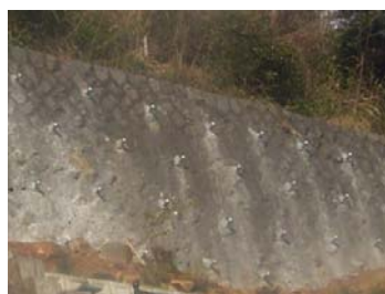
Photo 3 施工現場全景 Construction Site
