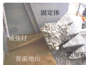
Fig. 4 ピンナップ工法の施工概要 Outline of Pin-Up Method
