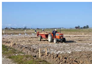
Photo 5 木材チップおよび補助材の散布・混合 Improvement works to using woodchip-mixed materials
