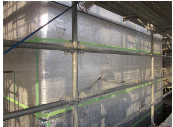
Photo 2 橋脚への養生シートの貼付け状況 Attachment Situation of Cure Sheet to Pier
