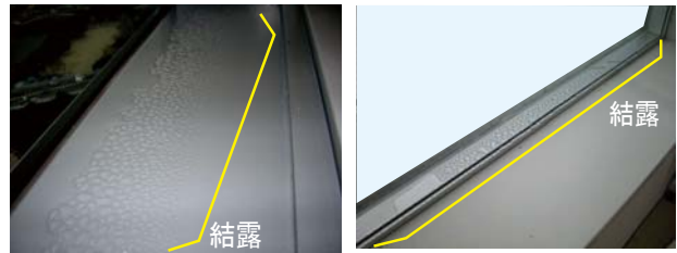
Photo 2 アルミフレームに生じた結露の例 Condensation Occurring on an Aluminum Frame without Thermal Break
