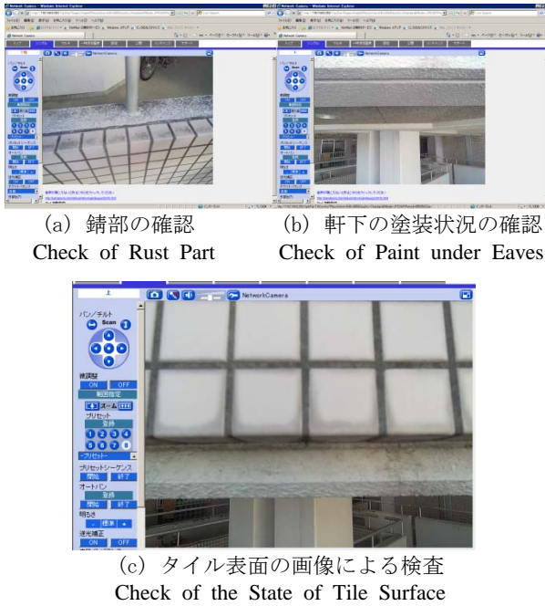
Fig. 6 自動取得画像の一例 Examples of the Automatically Acquired Picture
