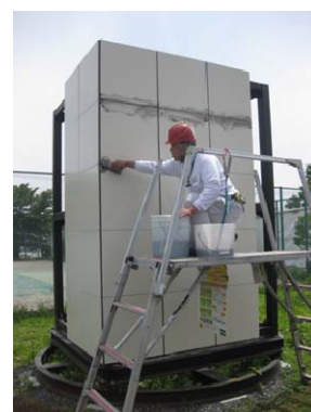
4)目地モルタルの充填
