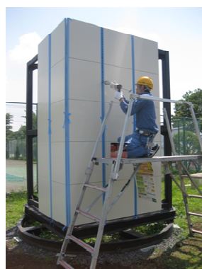
3)板間シーリング
