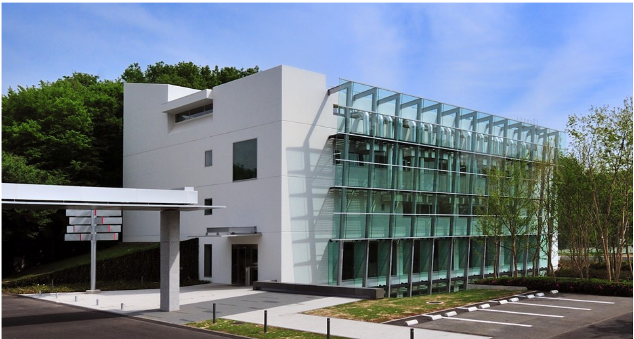
Photo 6 コンバージョン工事後の材料化学実験棟 Exterior View after Conversion
