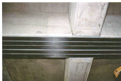
Photo 5 CFRPラミネート工法 CFRP Laminate
