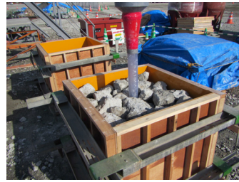
Photo 6 ブロックの作製状況 (プレパックドコンクリート工法) Casting of Block (Pre-packed Concrete Method)
