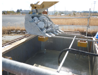
(b) 根固めブロック (ポストパックド コンクリート工法)
