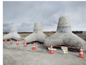
(a) 消波ブロック (プレパックド コンクリート工法)
