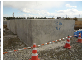
(b) 根固めブロック (ポストパックド コンクリート工法)
