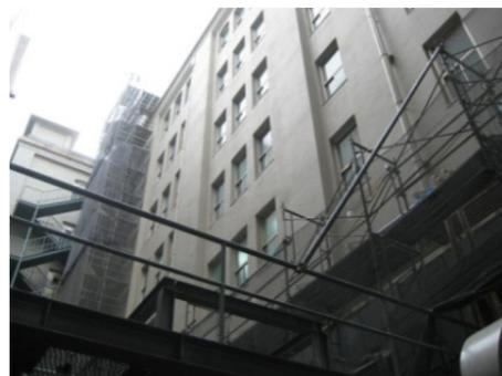
Photo 5 適用物件の外付け耐震補強面
