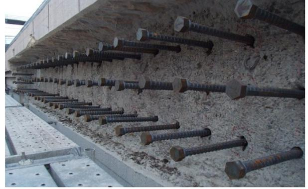
(b) あと施工アンカー打設状況
