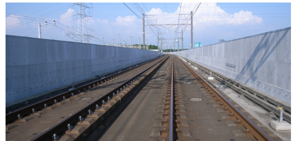
Photo 5 完成状況（軌道内） Parapet Wall after applying this method
