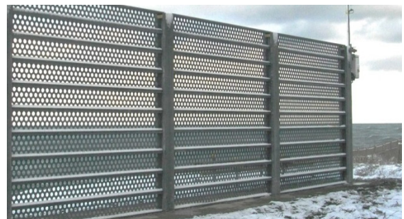
Photo 3 設置したスリムクリート製防風柵 Slim-Crete Wind-breaking Fence
