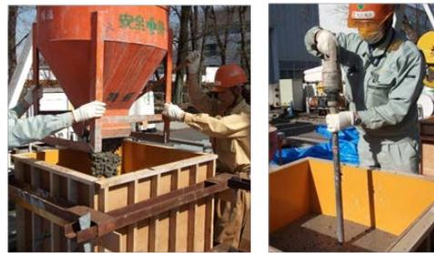
Photo 1 コンクリートの打込み状況
