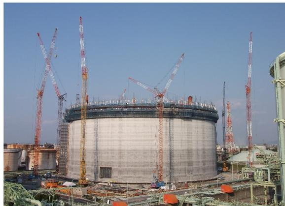
Photo 5 スリップフォーム工法で構築したPC防液堤
