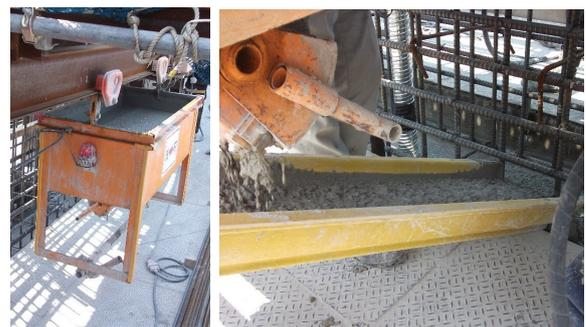
搬送用バケットによる運搬 (左) と開閉口からのシュートを介しての打込み (右) の状況
