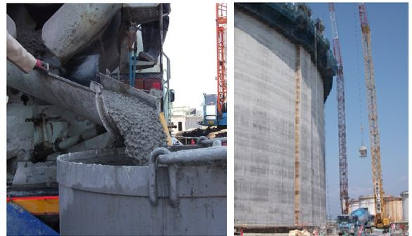
荷揚げ用バケットへの荷卸し (左) とクレーンによる吊り上げ (右) の状況
