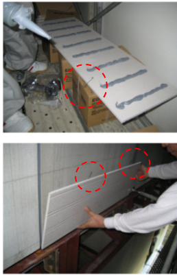
Photo 1 引き金物を用いた大形タイル張り工法
