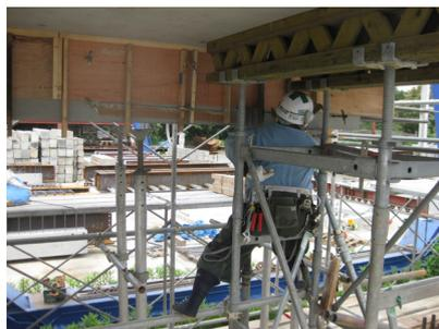
Photo 5 梁側型枠の取付
