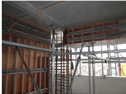
Photo 10 梁側型枠の取付
