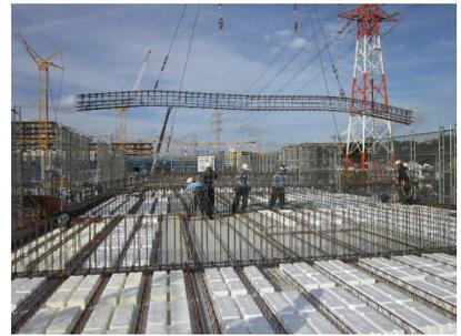
Photo 12 壁梁筋の取付
